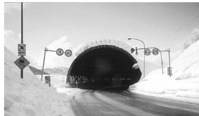
写真11.6 スノーシェルター
